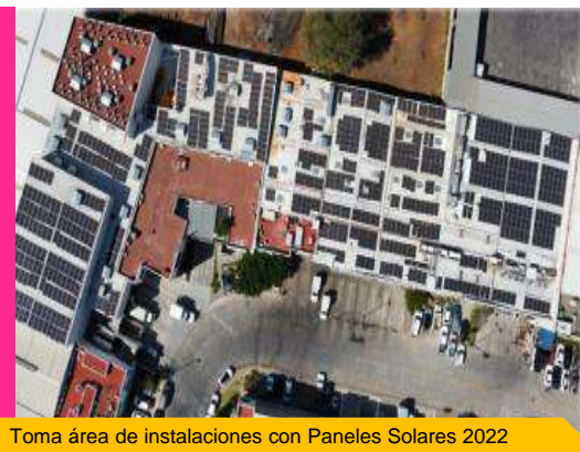
Toma área de instalaciones con Paneles Solares 2022
